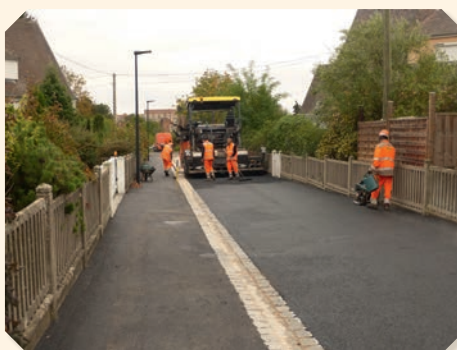
Rue du Château d'eau Pose des enrobés
