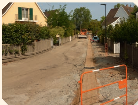
Rue du Château d'eau Assainissement pluvial
