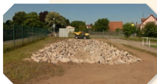
Enrochement du bassin
