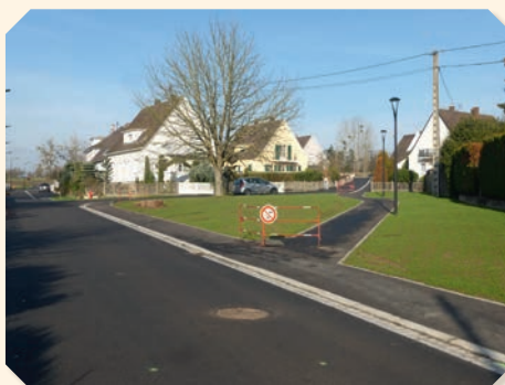
Rue du Château d'eau Vue d'ensemble
