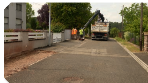
Rue du Muhlfeld
