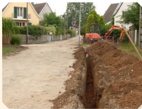
Rue du Château d'eau Enfouissement de réseaux
