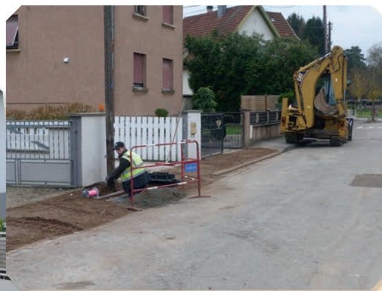
Rue du Parc - Enfouissement du réseau téléphonique
