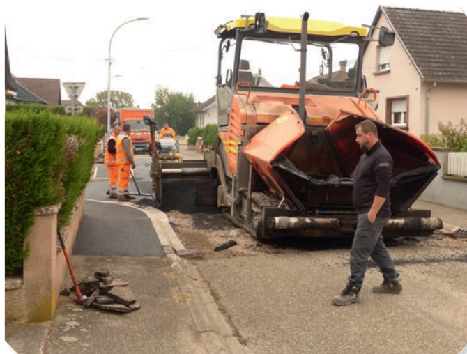
Place des Roses Pose des enrobés sur les parkings
