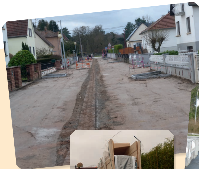
Rue du parc Terrassement et assainissement pluvial
