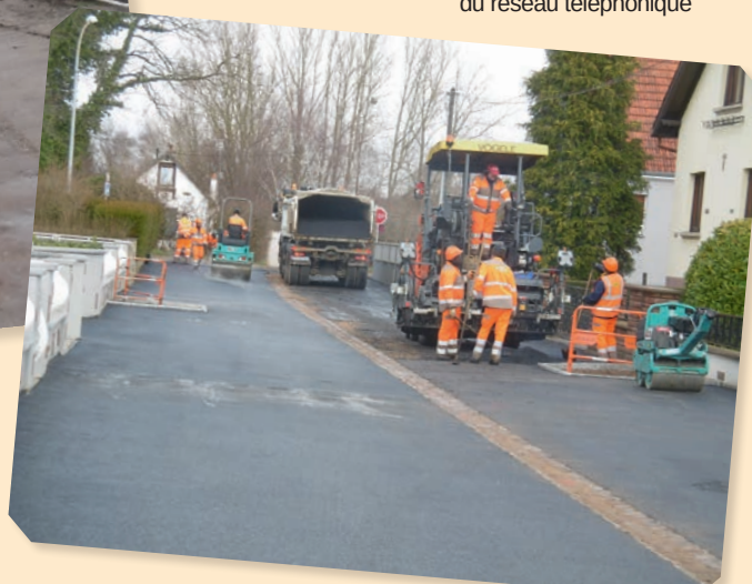
Rue du Parc - Pose des enrobés
