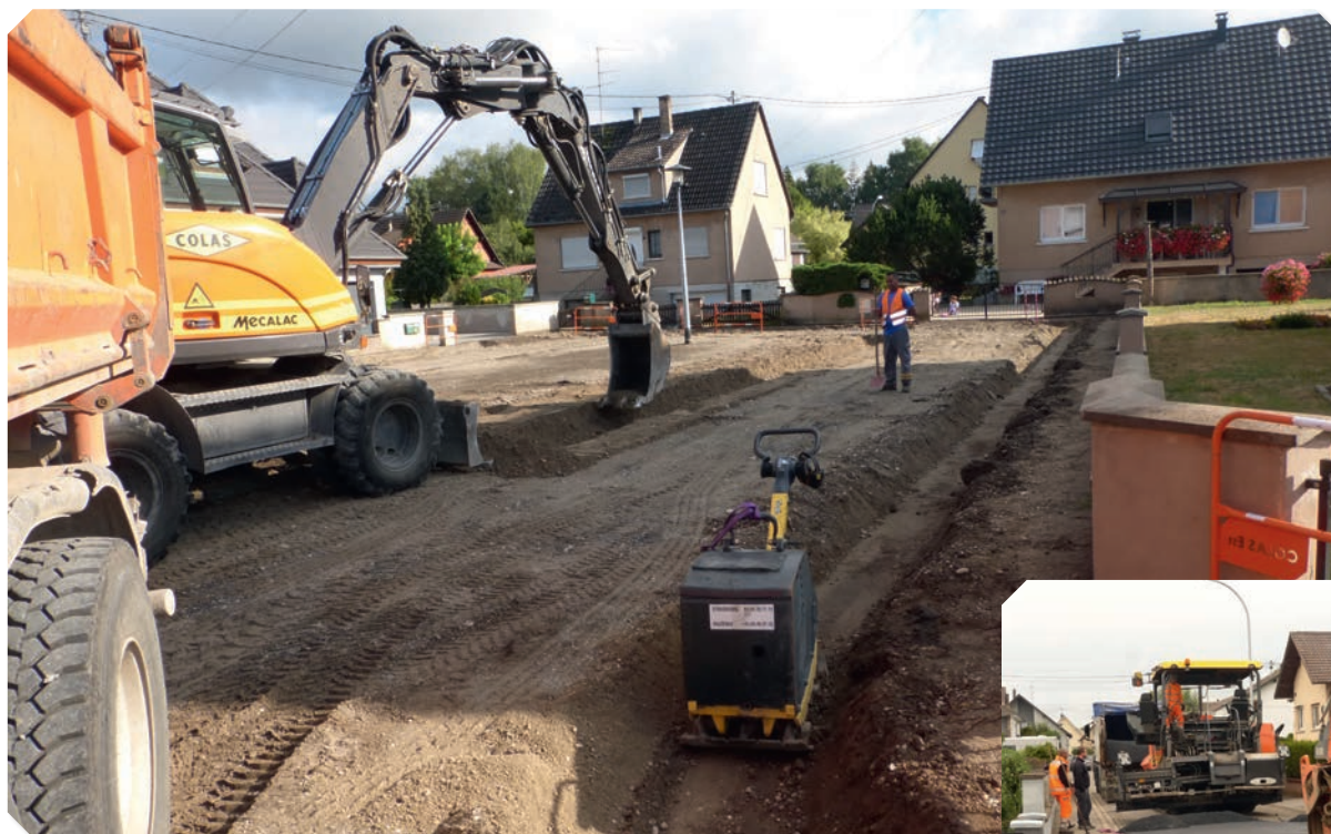
Rue et place des Roses Terrassement et reprofilage
