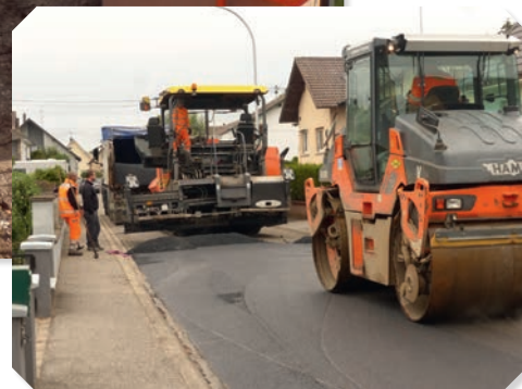
Rue des Roses Pose des enrobés
